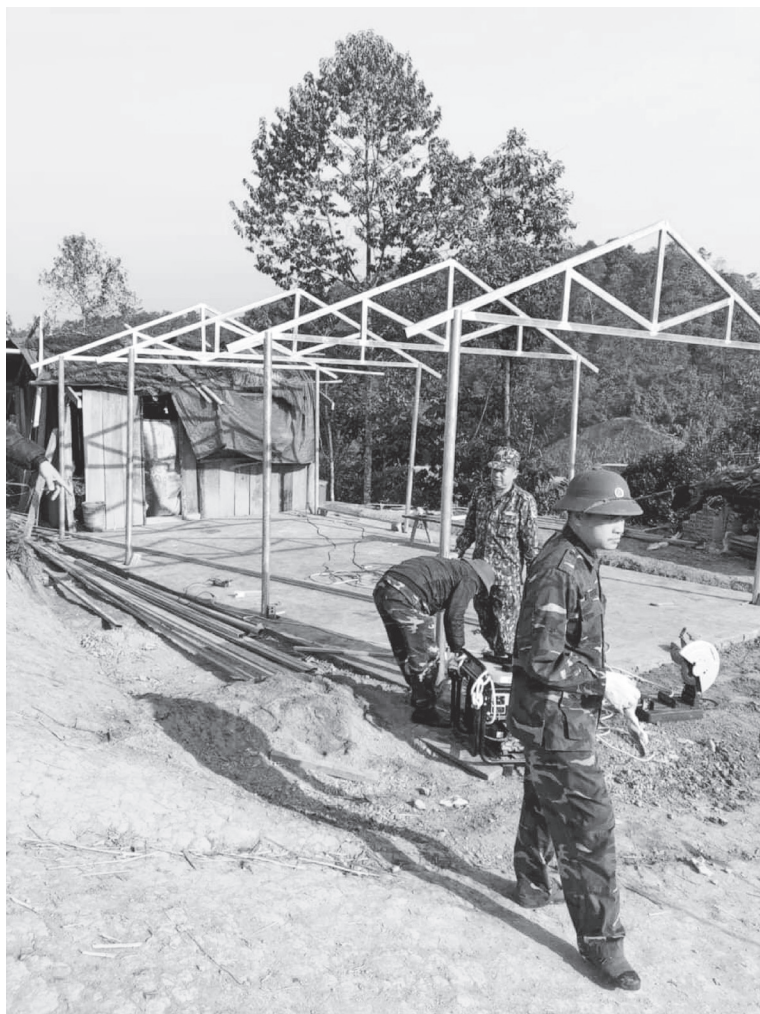
Tổ công tác Bộ CHQS tỉnh triển khai dựng khu nhà cho người dân.
